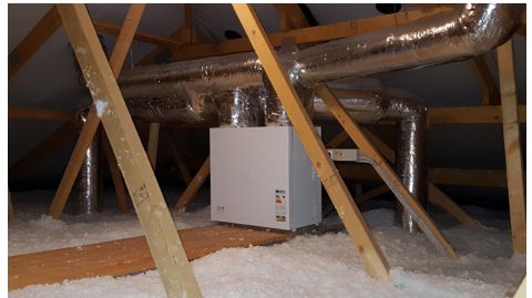
Aggregatet er placeret på loftet
