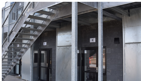
Sorte yderskærme er valgt til projektet for at passe til bygningernes facadebeklædning
